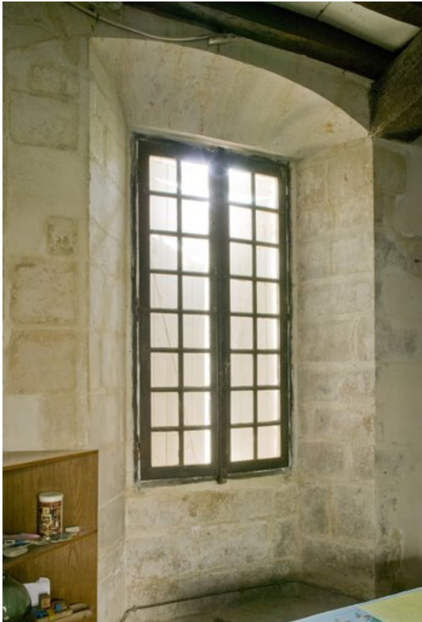
Vue intérieure de la pièce au nord du vestibule, montrant une ouverture gothique fortement ébrasée, réduite au XVIIIe siècle.
