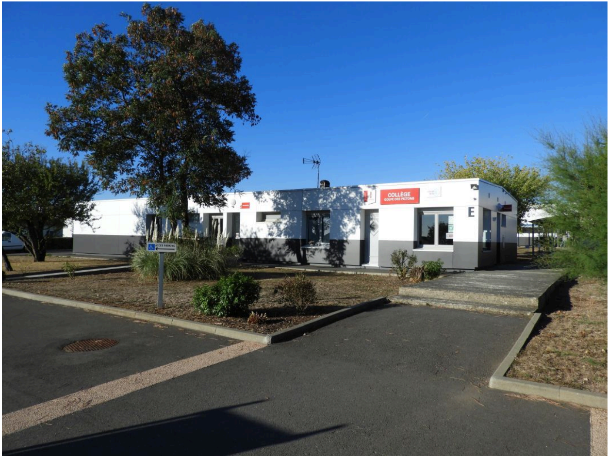
Le bâtiment d'accueil et d'administration vu depuis le nord-est.
