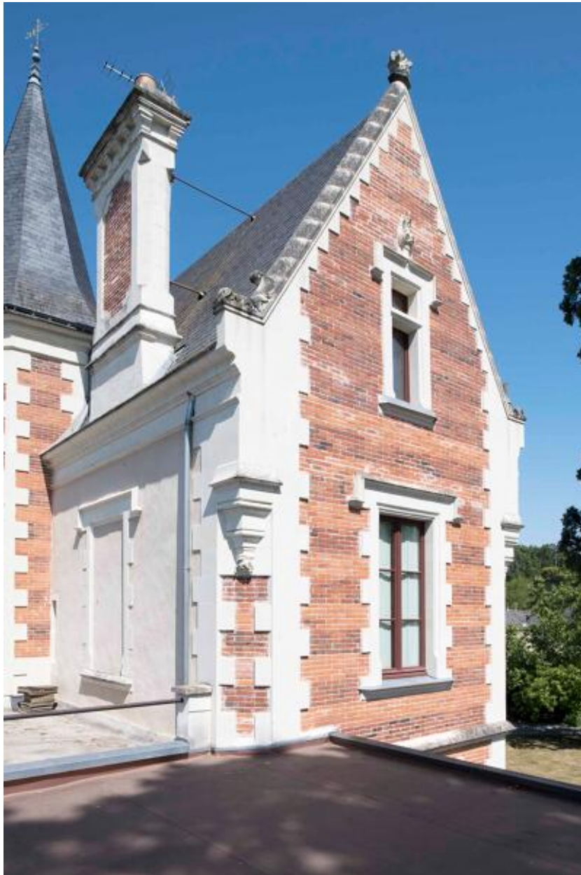
Détail du pignon ouest.
