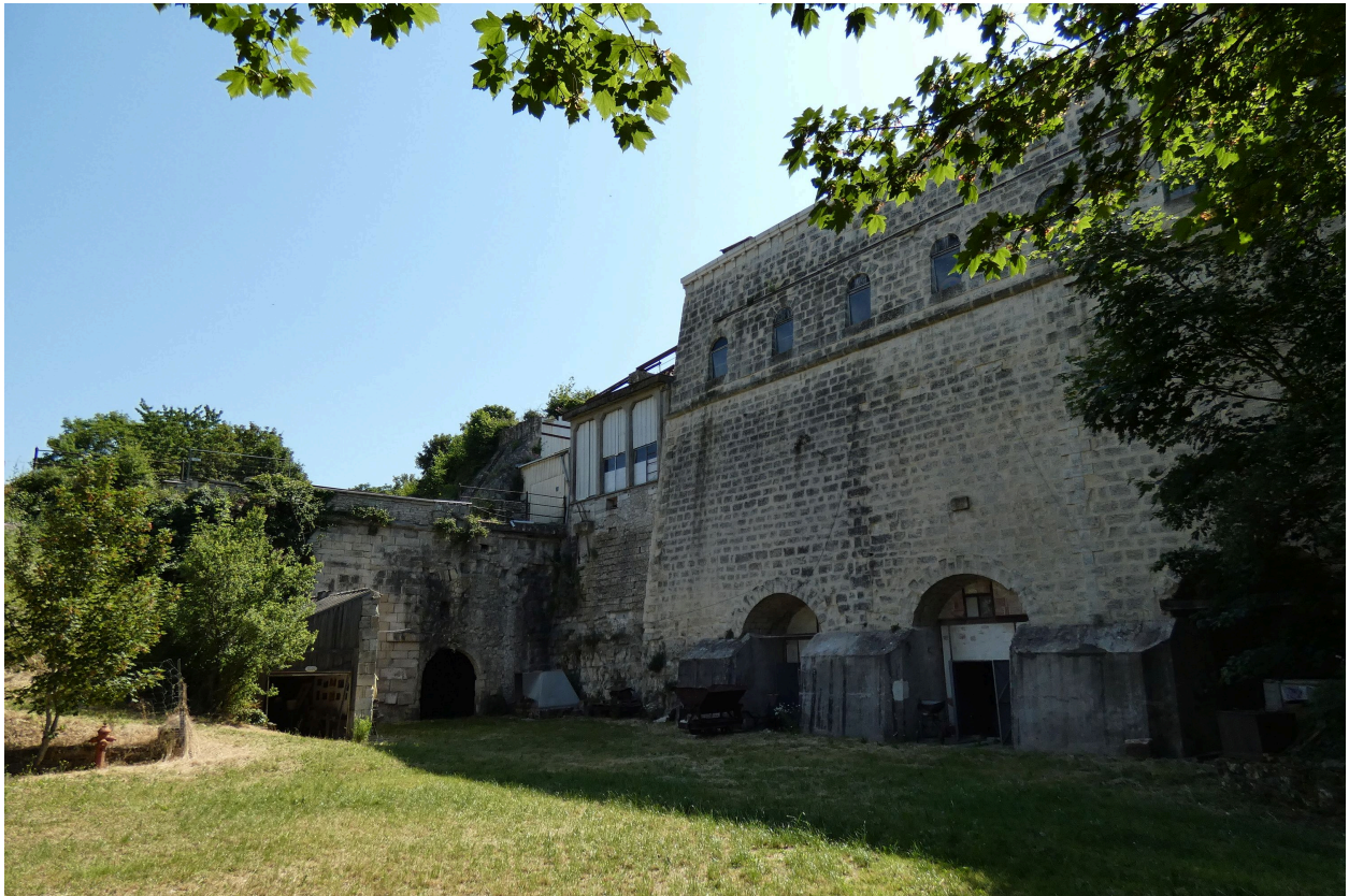
Le bâtiment des fours à chaux vu depuis l'ouest.
