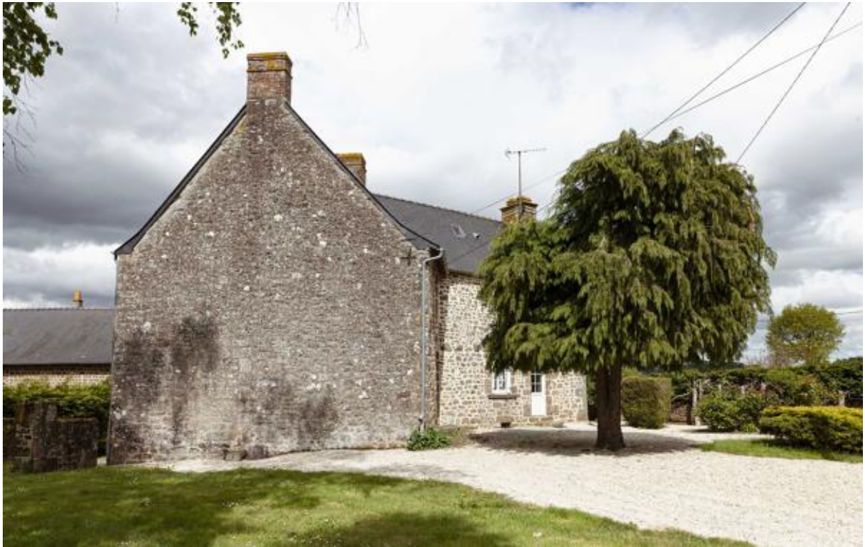
Maison au sud du village (2023/149 B 32).
