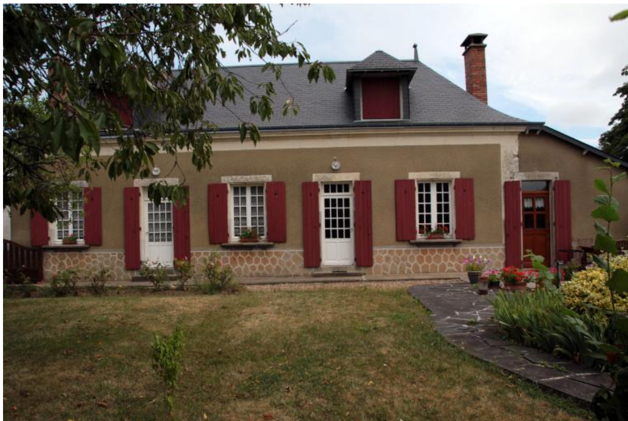
Maison : façade antérieure.
