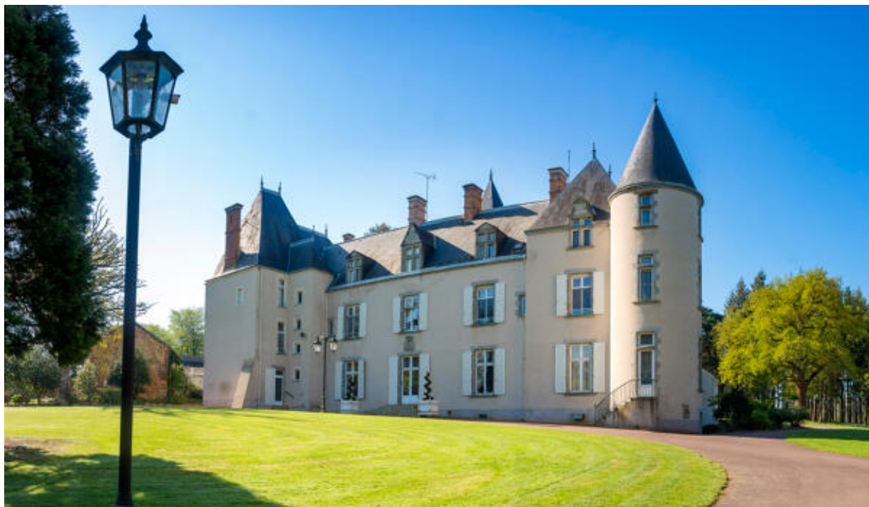
La façade antérieure du château.
