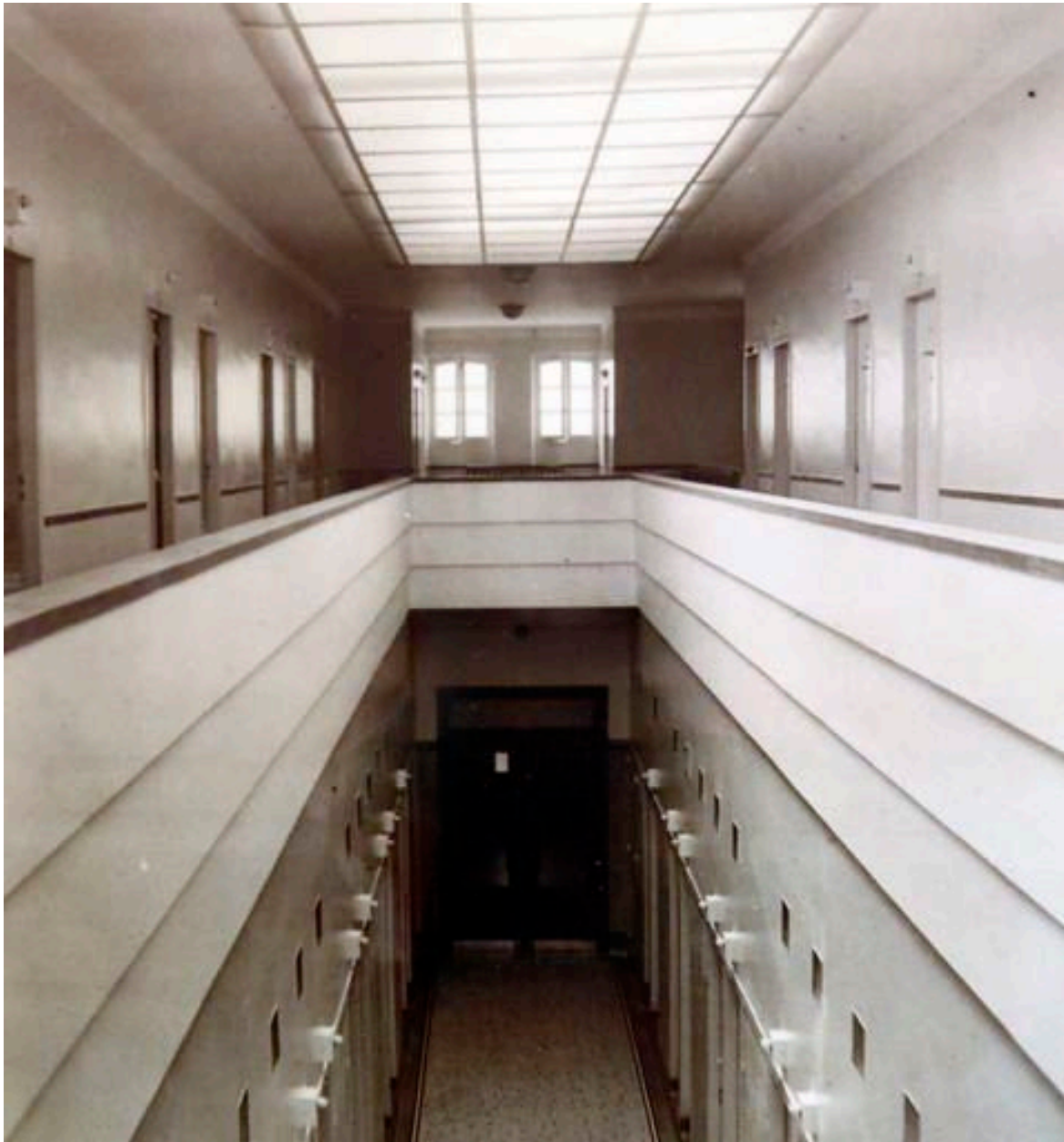
Salles de douches à l'étage, 1952.
