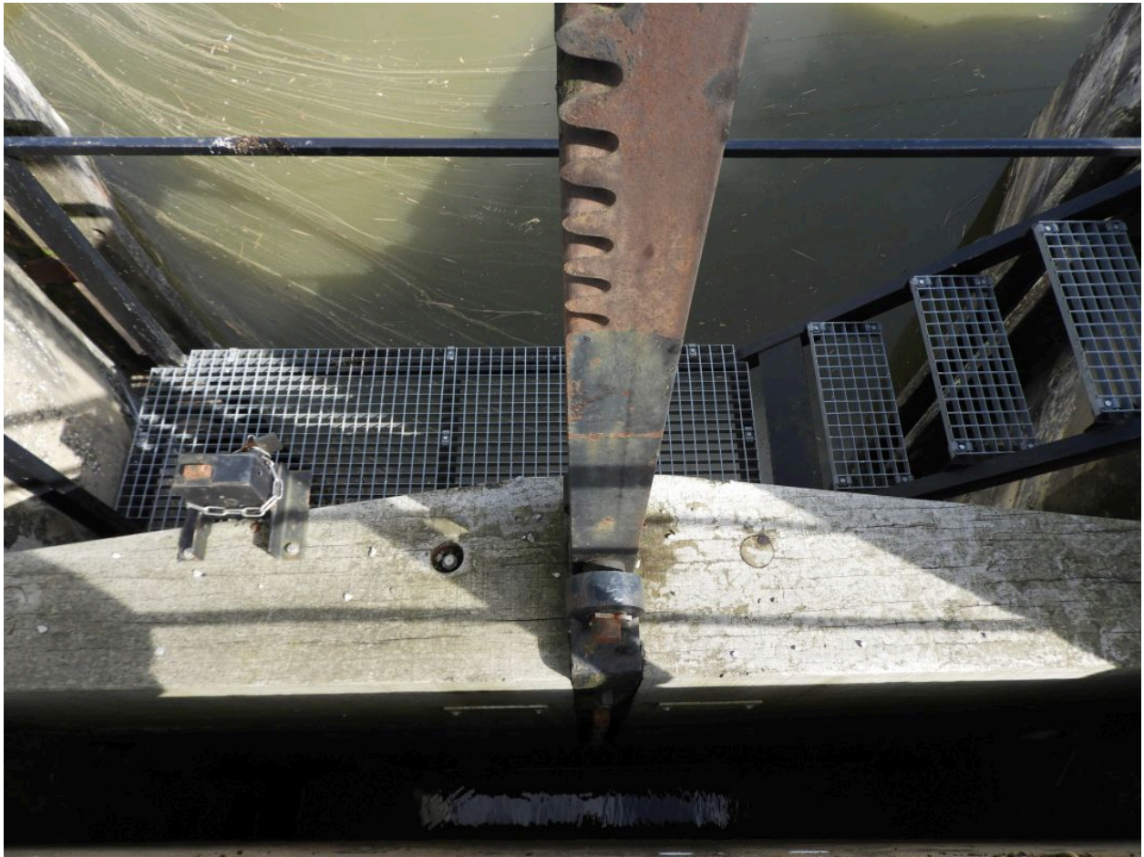
La vanne en bois à l'arrière de la porte, soutenue par une crémaillère.
