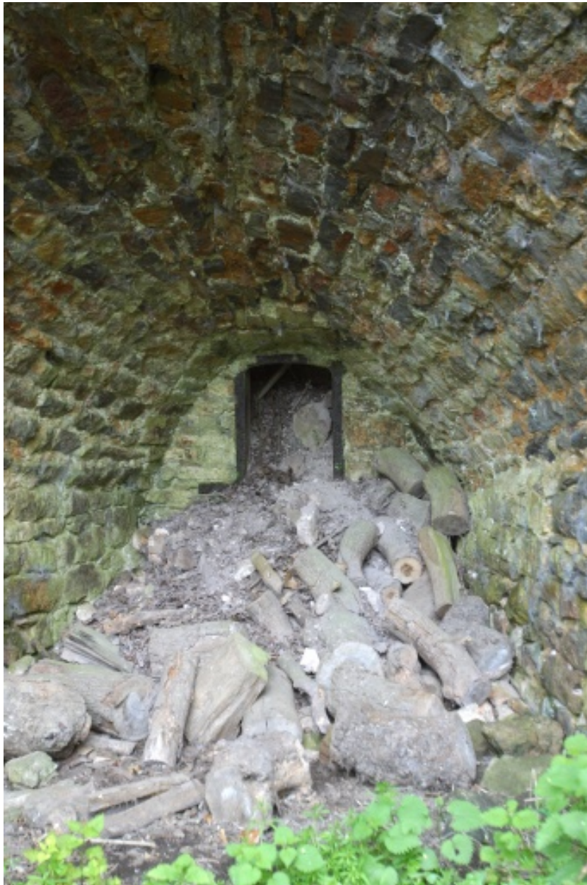
L'embrasure de l'ouverture de déchargement du second four.
