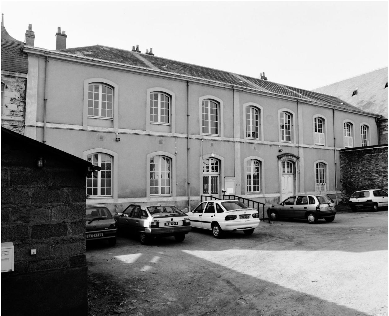
Aile dite des parloirs, façade nord, sur la cour d'entrée réservée à la marquise de Férolle (n°41 de la rue).
