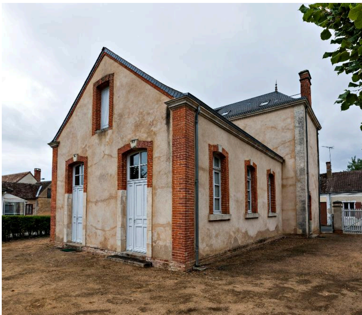
Le corps de bâtiment des classes.
