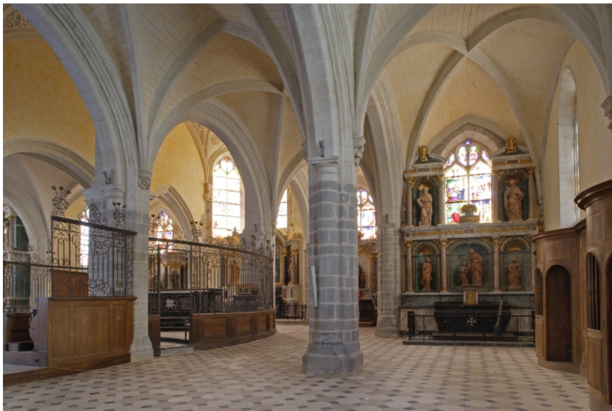
Choeur, collatéraux droit après restauration : vue d'ensemble vers l'abside.
