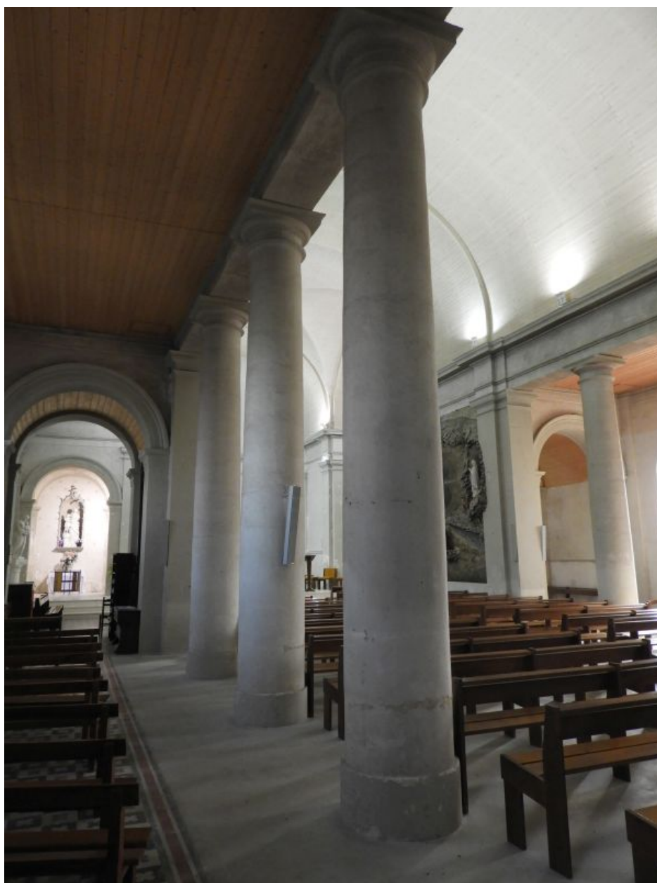
Le bas-côté nord vu depuis l'ouest.
