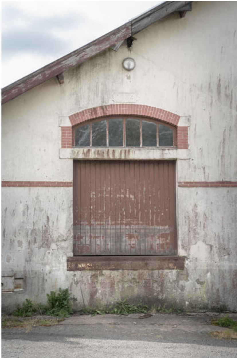
Quai de chargement du magasin principal.
