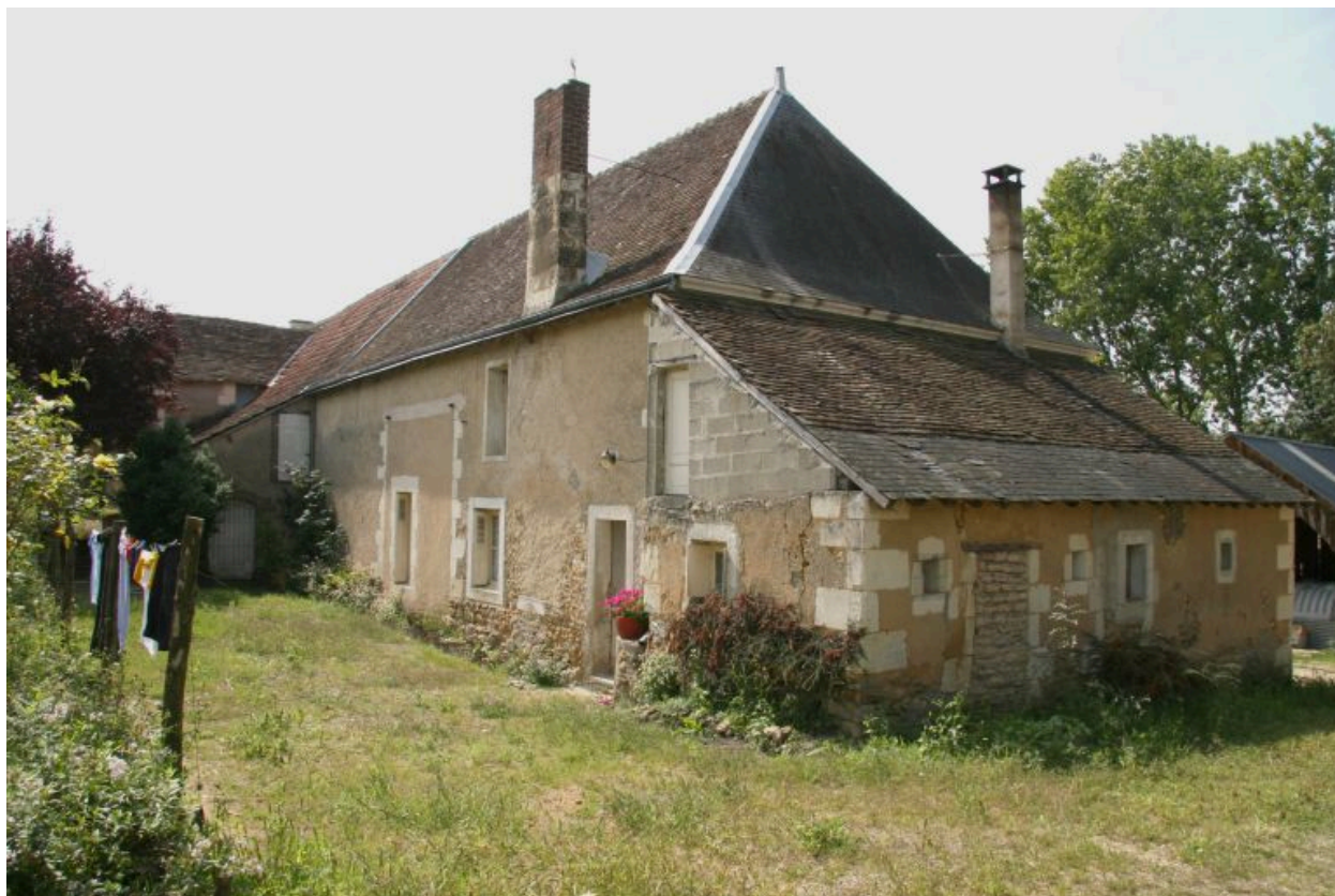
Les communs, aile ouest : façade postérieure.
