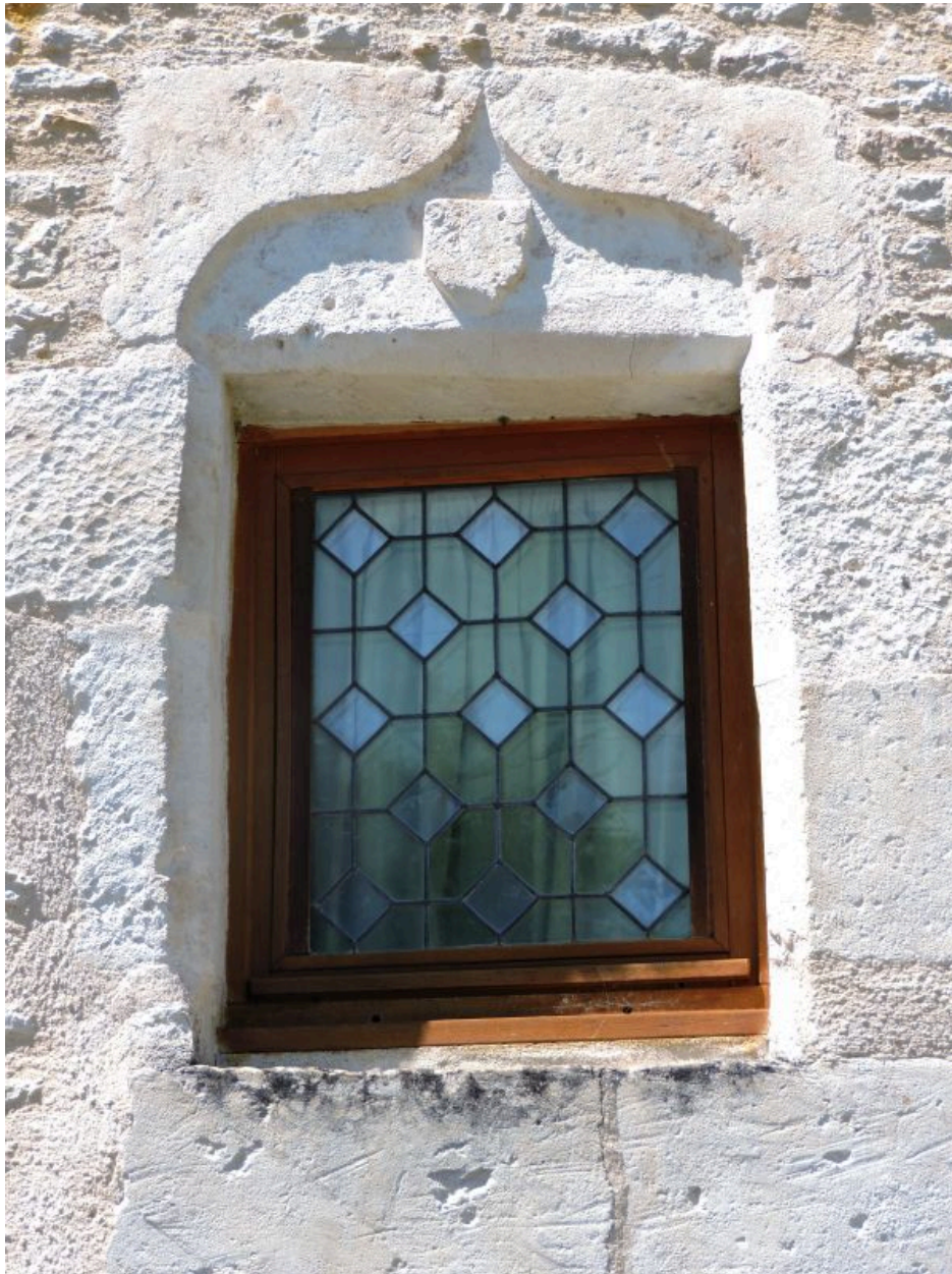
La baie avec linteau en accolade (15e-16e siècle) à l'étage.
