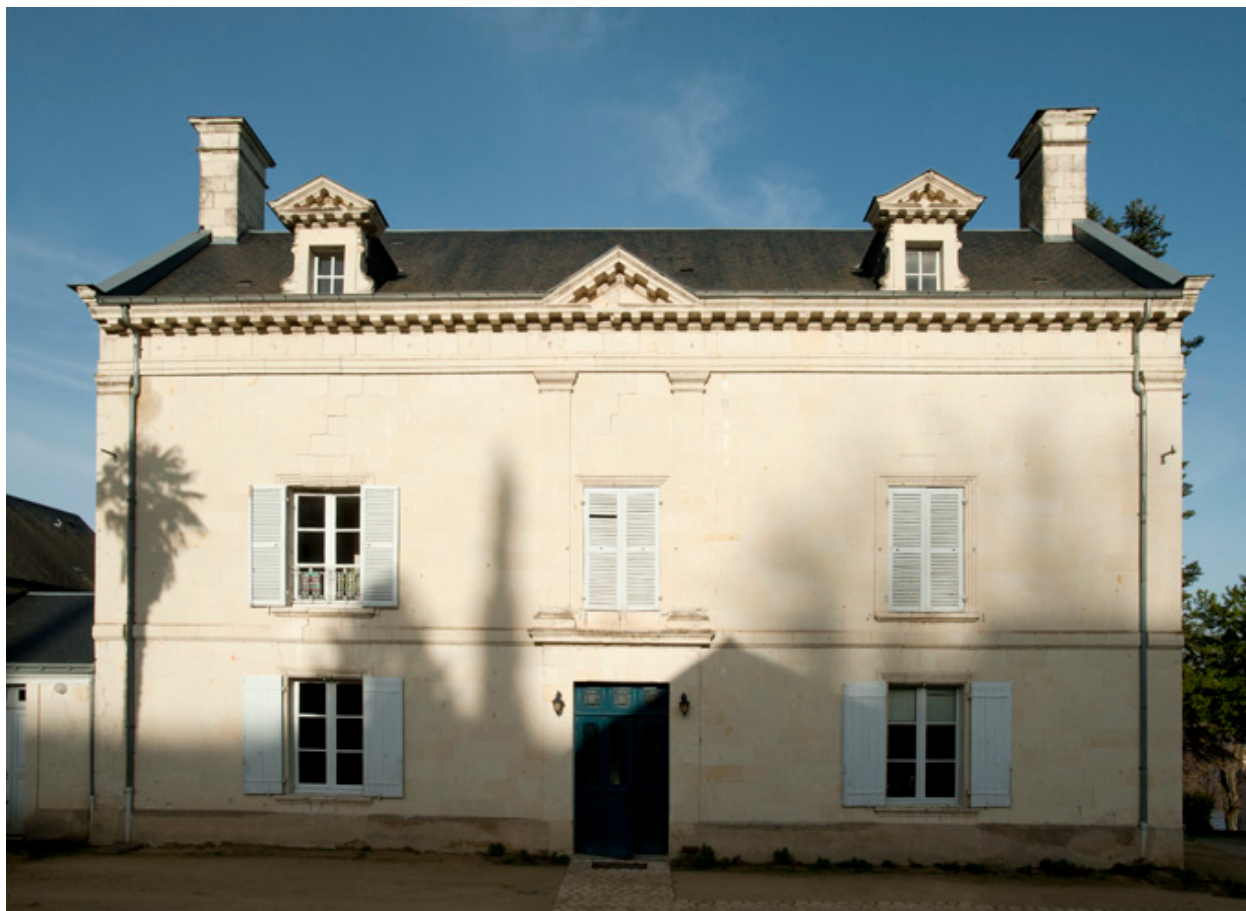
Vue générale (façade sud).
