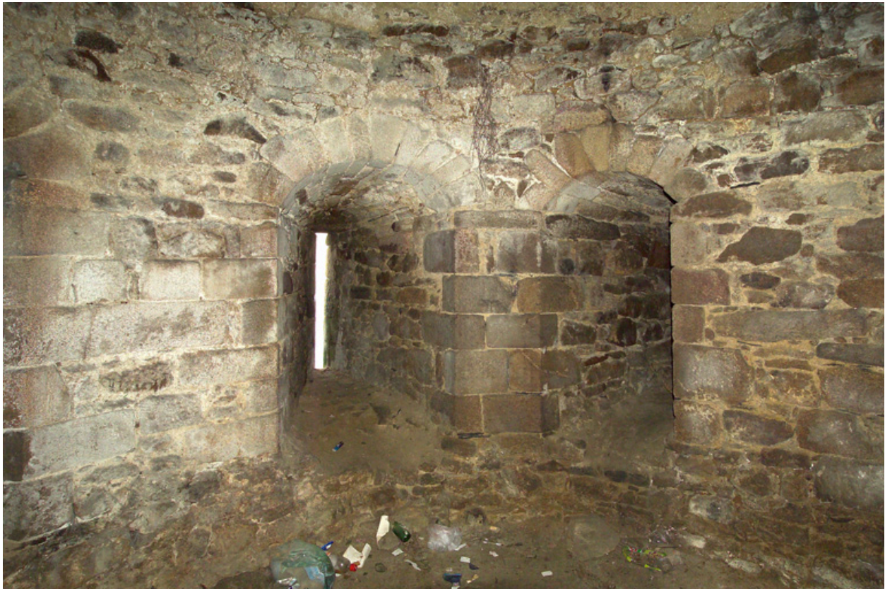
Ouvertures de tir au rez-de-chaussée.
