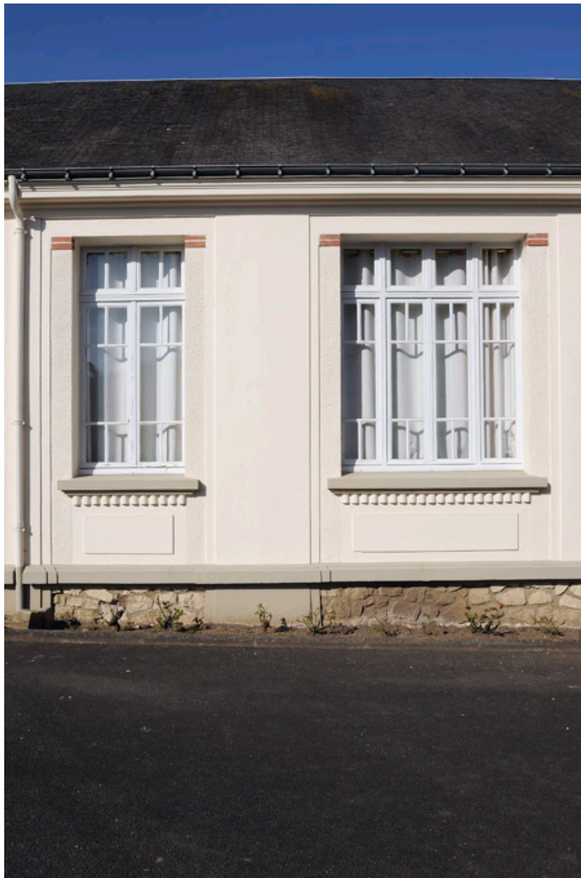
École : façade est, détail de deux baies (1)
