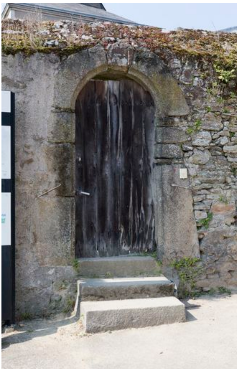
Porte d'accès au presbytère.
