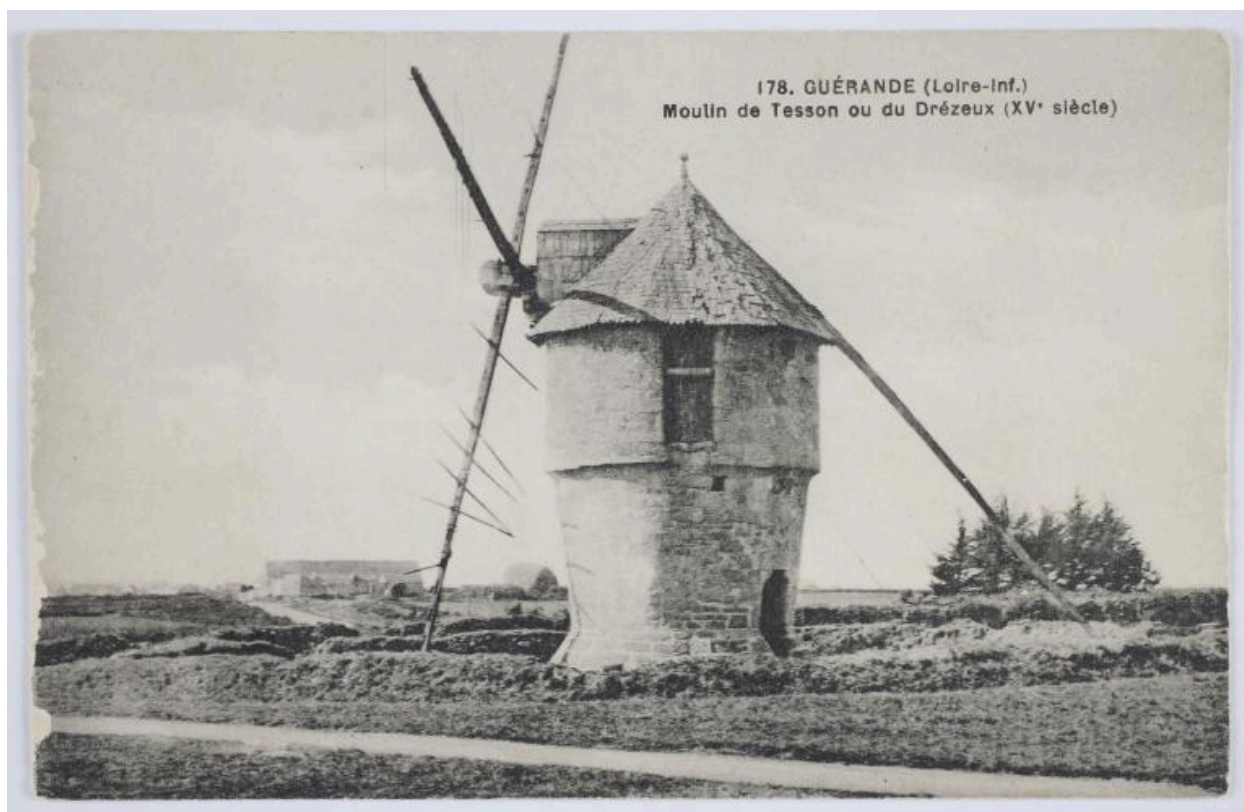
Moulin de Tesson ou du Drézeux (XVe siècle). Vue d'ensemble du moulin depuis le sud.
