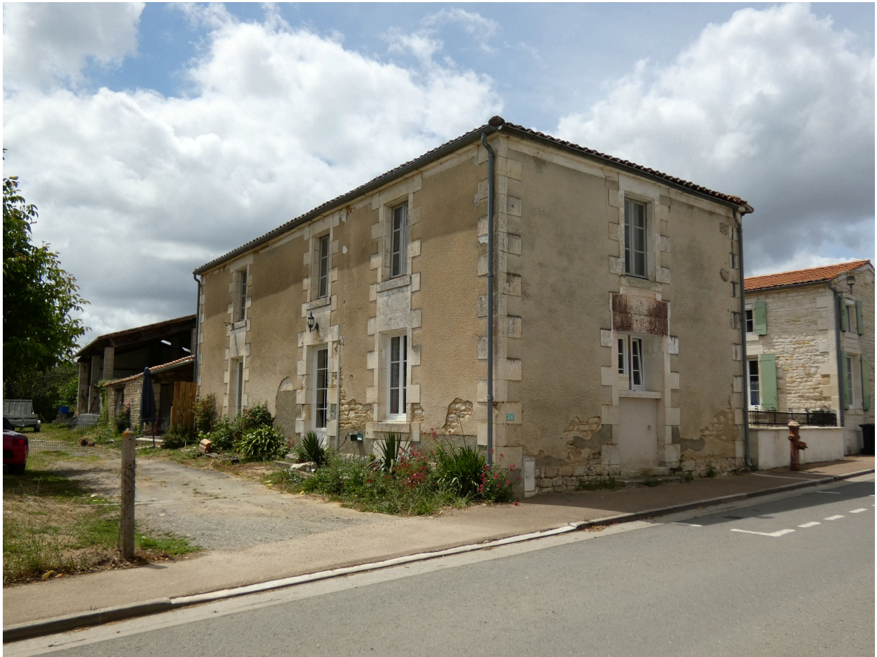
Le logis et ses dépendances vus depuis le sud-est.
