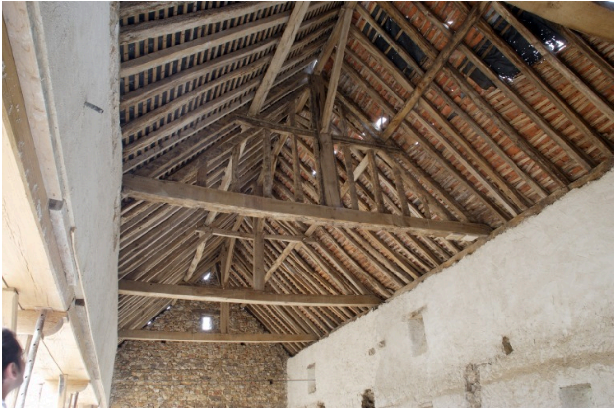
La charpente de l'ancien logement-étable vue depuis le sud.
