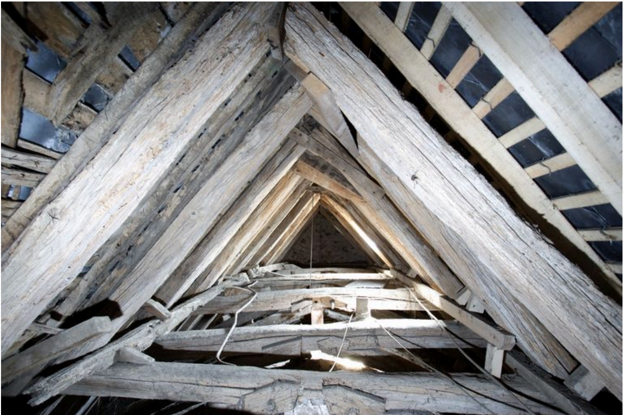
Charpente du choeur : vue d'ensemble depuis l'ouest à partir de la 2e ferme.
