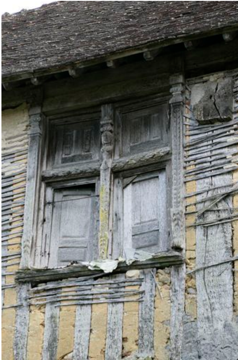
Logis, fenêtre de l'élévation postérieure.
