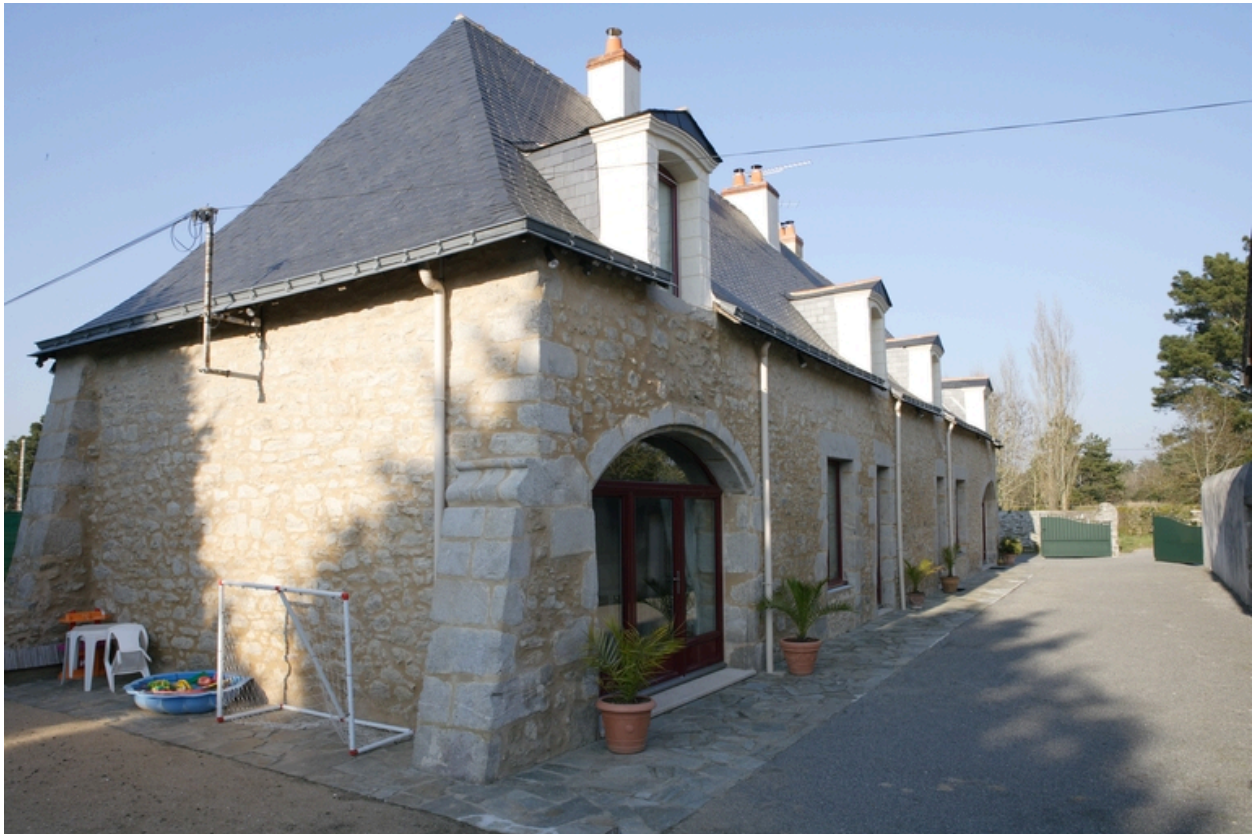
Vue des communs depuis le sud-est.
