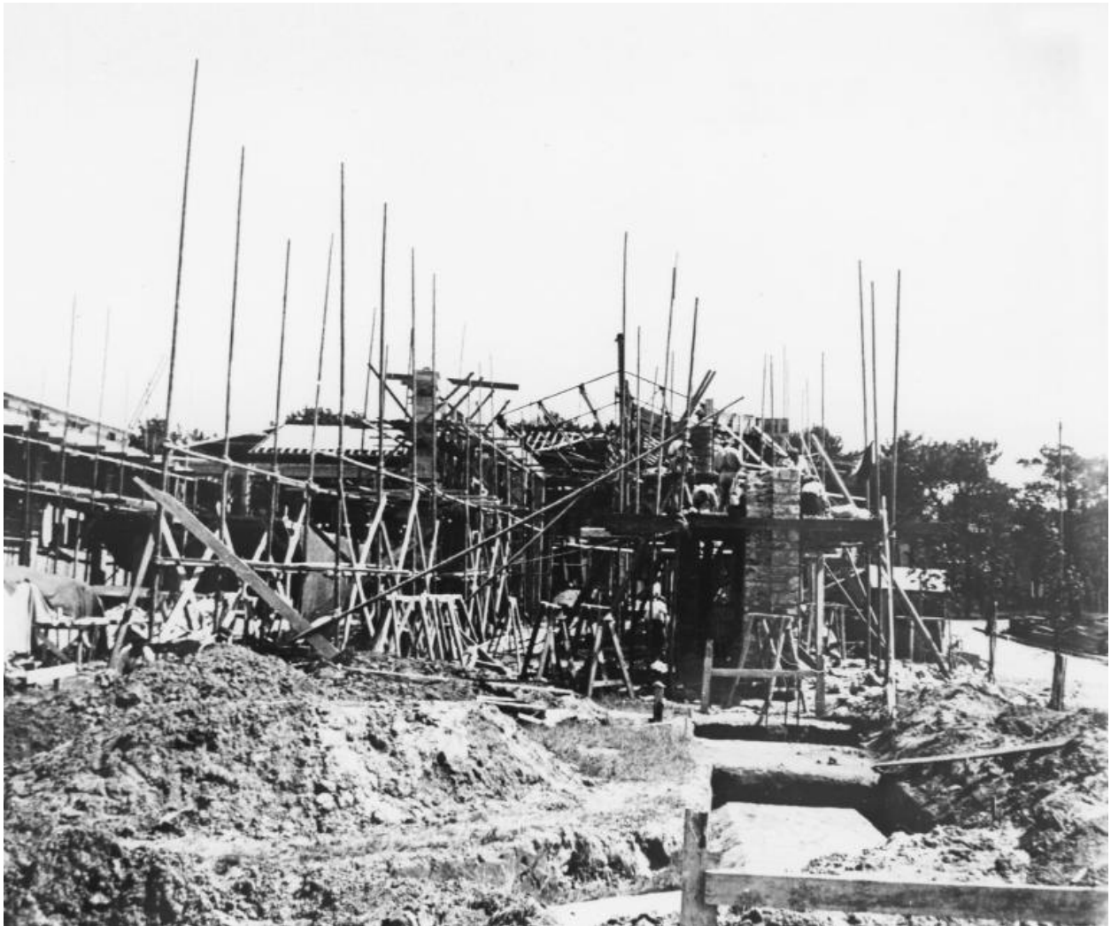
Vue du nord : atelier du garage Citroën en construction en 1928.
