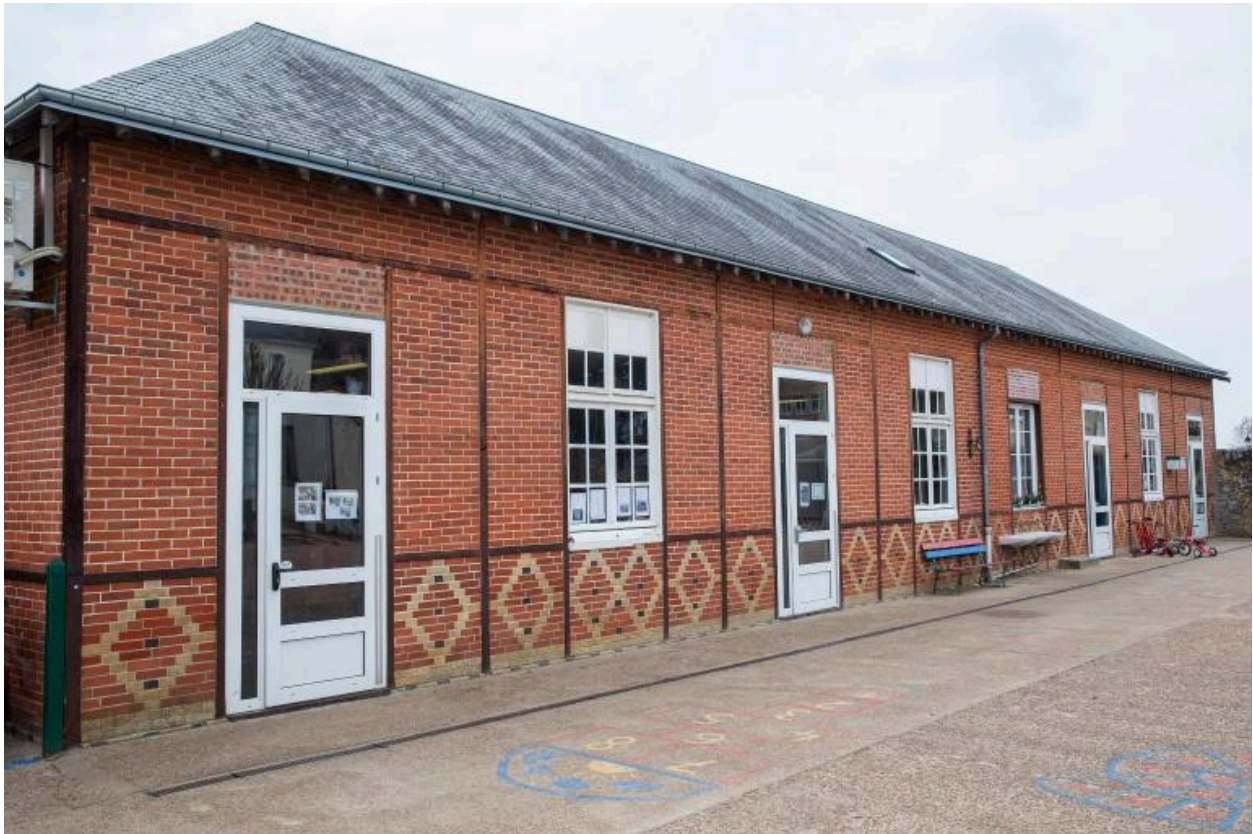
Le bâtiment des classes, côté cour.
