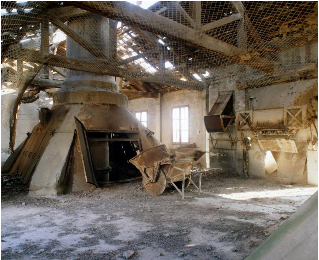
Usine de chaux, plate-forme supérieure des fours, trémies de déchargement du skip et portes de chargement d'un des fours
