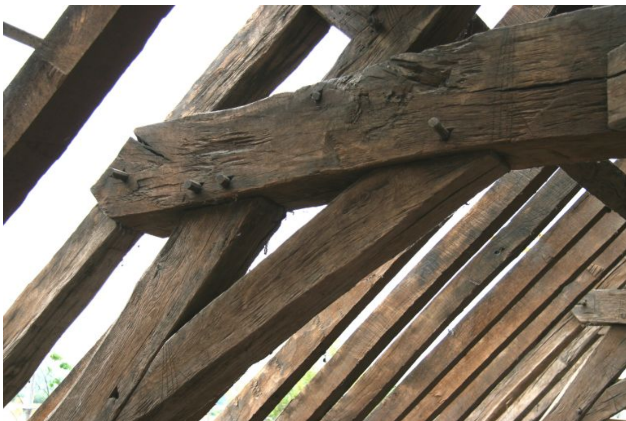
Charpente de la dépendance ancienne : assemblages.
