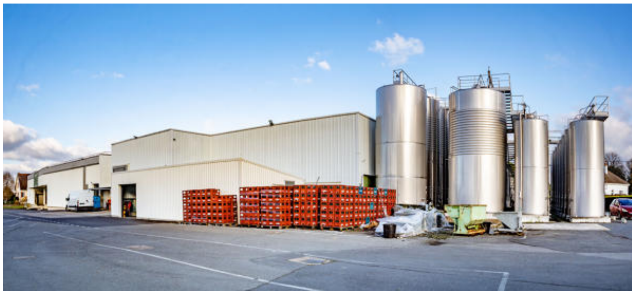
Angle sud-ouest du bâtiment. Cuverie.
