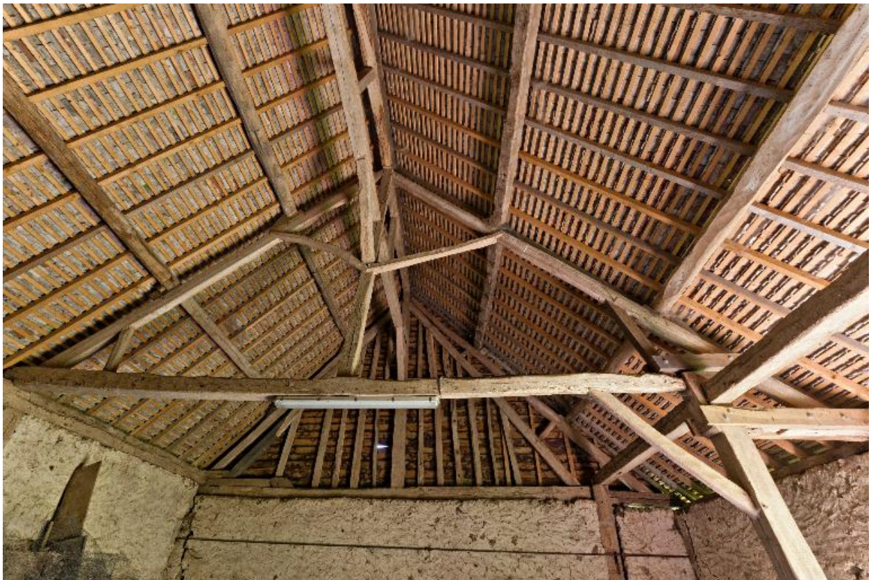
Vue des charpentes de la partie droite de la grange.
