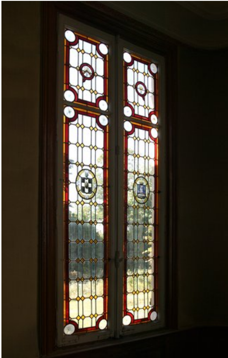
Vue d'ensemble de la verrière du mur sud de la cage d'escalier.
