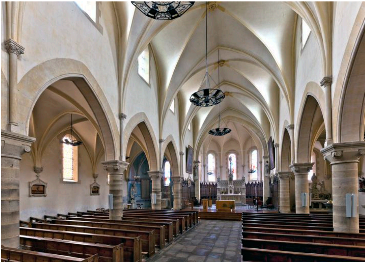
Vue d'ensemble de le nef, des bas-côtés et du chœur depuis l'ouest.
