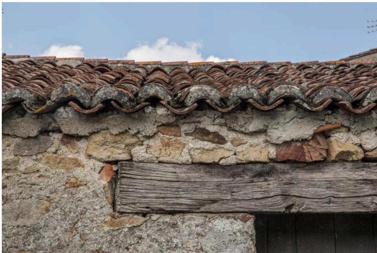
Rangée de tuiles formant l'égout du toit d'une habitation. Les Laures, cadastre 2018, HN 01-97.
