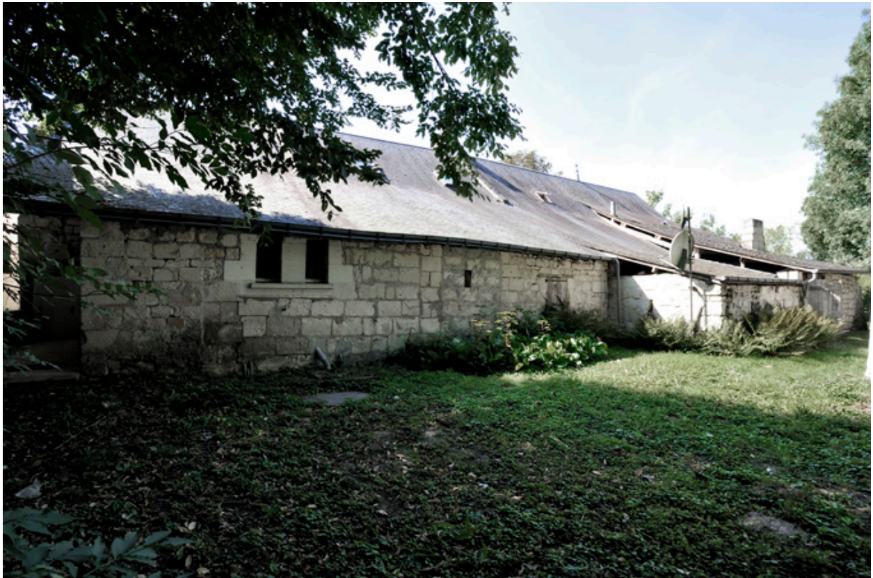
Façade postérieure de la rangée de maisons, avec agrandissements en profondeur.
