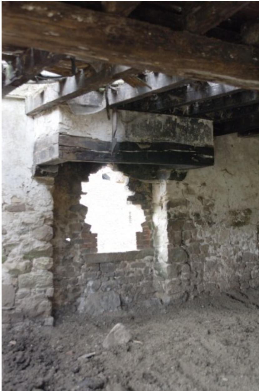
Le logis, pièce ouest : la cheminée et les vestiges de son four.
