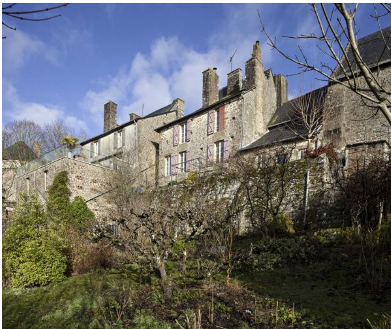
Façades sur jardins et murs de clôture des maisons des 16-20 rue du Château.
