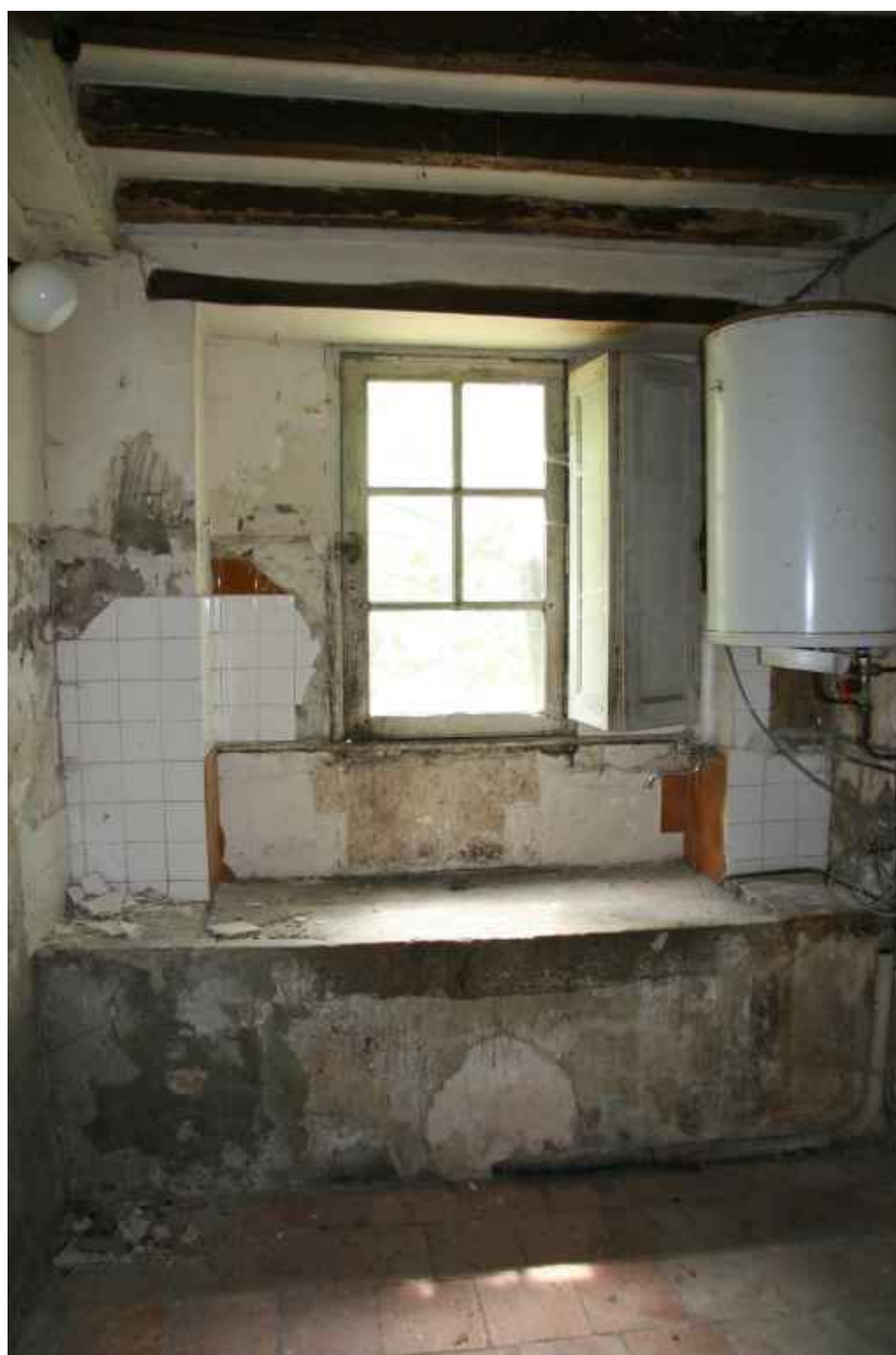
Bâtiments accolés au pignon : évier.
