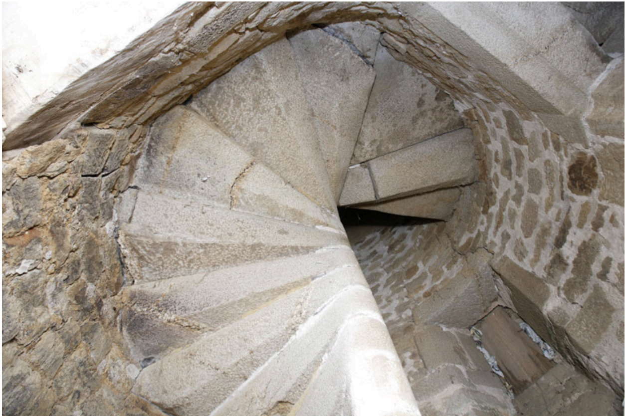
Logis. Tour d'escalier. Vue de l'escalier en vis.
