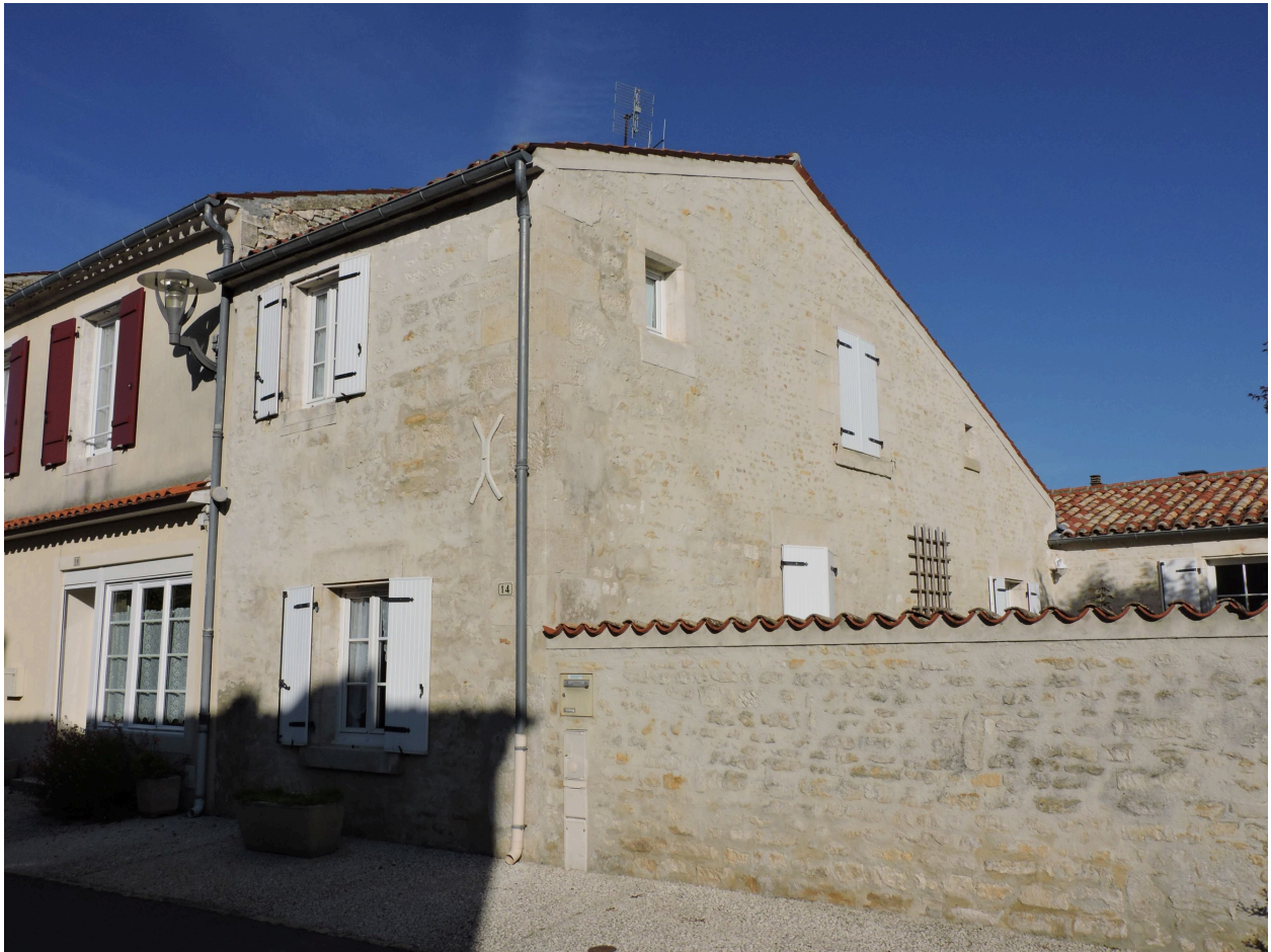
Vue depuis le sud-est.
