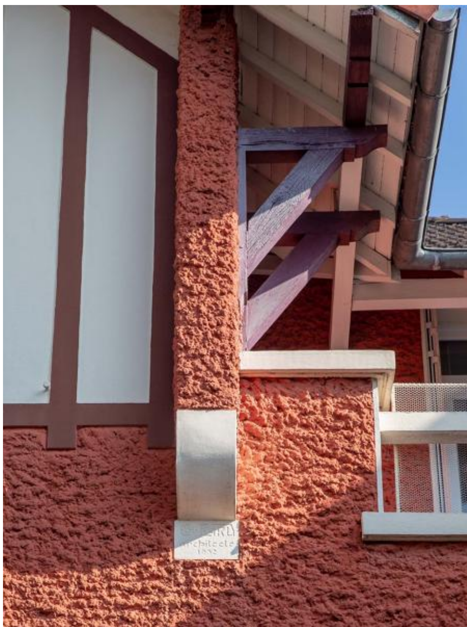
Vue de la plaque d'architecte (Plard) en façade de la maison de type villégiature rue du Pavé.
