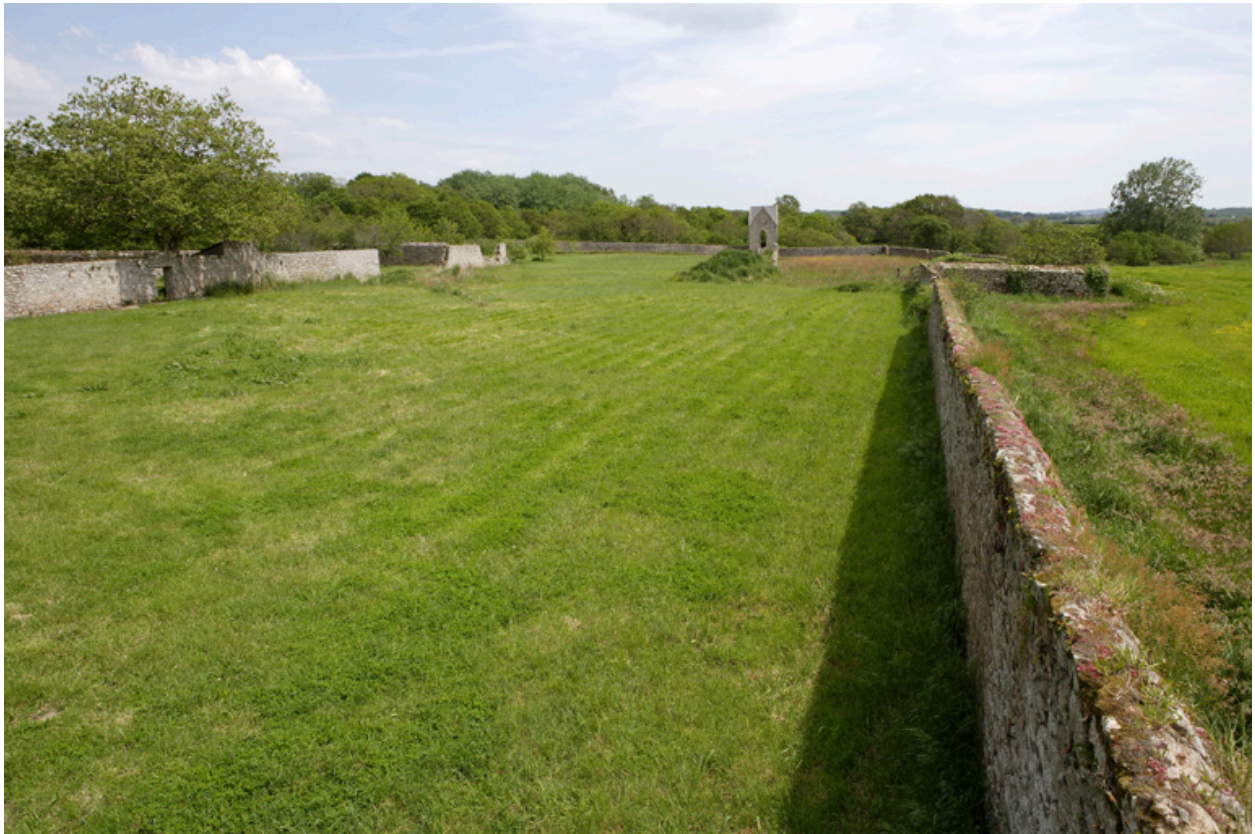
Vue du mur de clôture et de la chapelle (au fond) depuis la tour octogonale.
