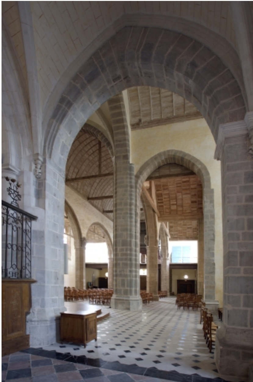
Collatéral gauche restauré : vue d'ensemble vers le sud.
