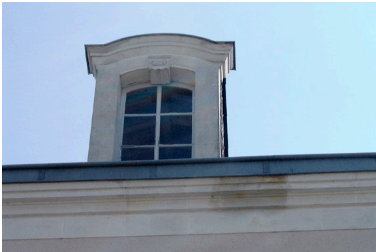
Détail de lucarne.
