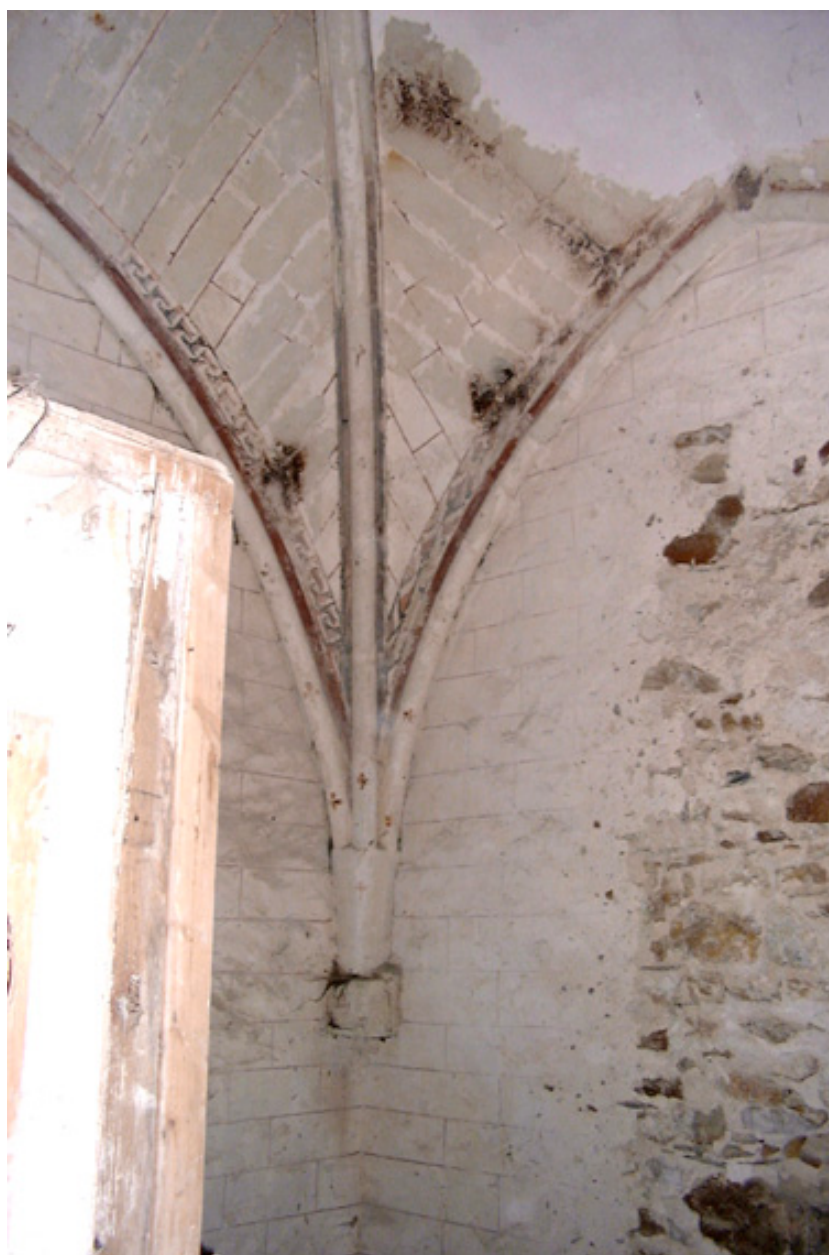
Tour de clocher : détail de la voûte et du décor peint.
