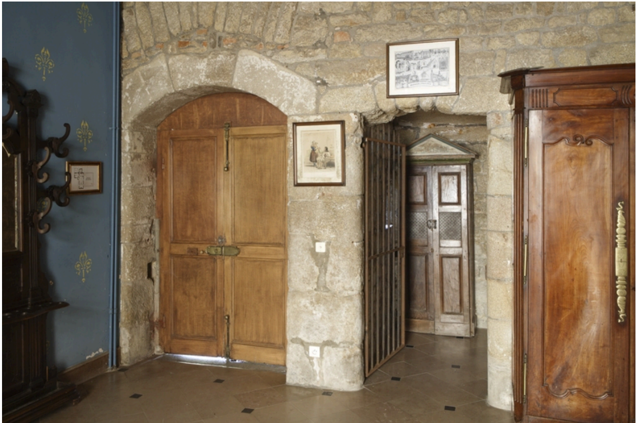
Logis. Aile est. Rez-de-chaussée. Détail de l'embrasure de la porte d'entrée.
