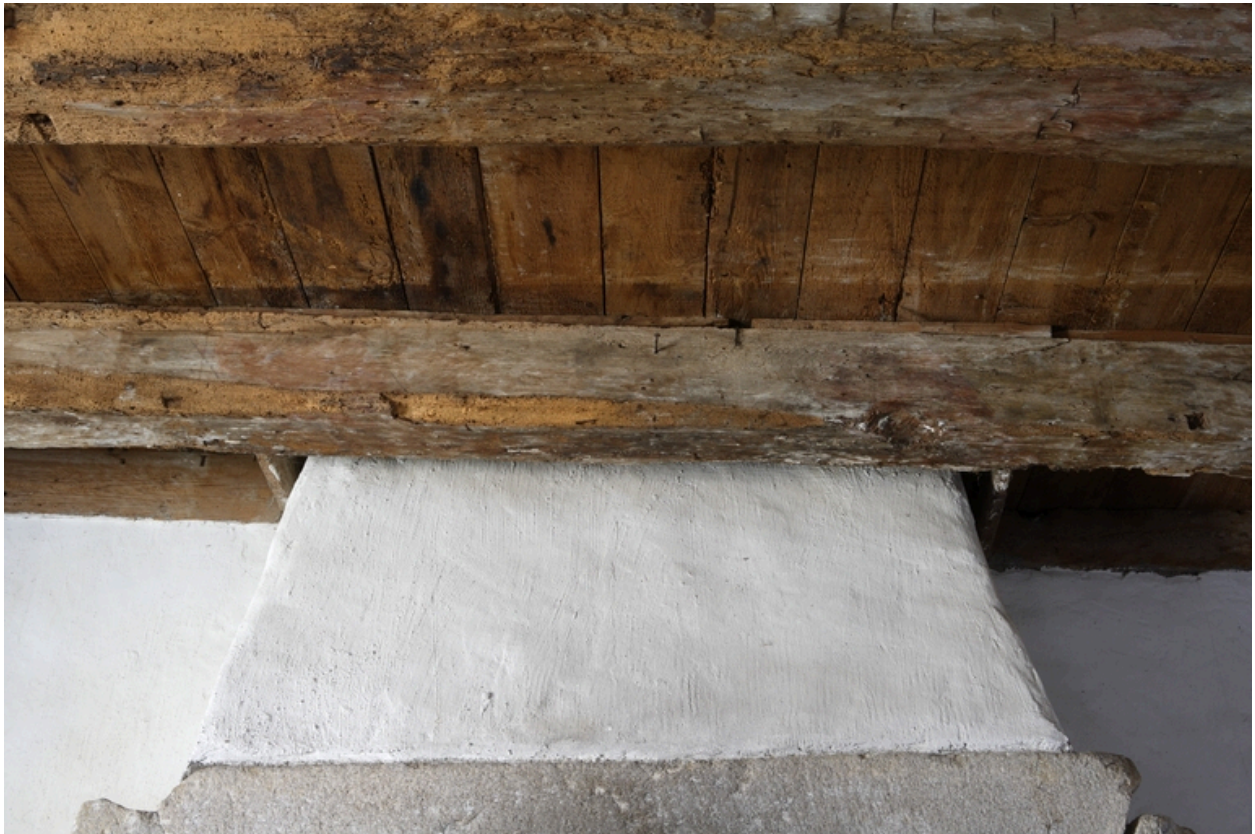
Aile ouest. Salle haute. Détail du décor peint sur les poutres du plafond.
