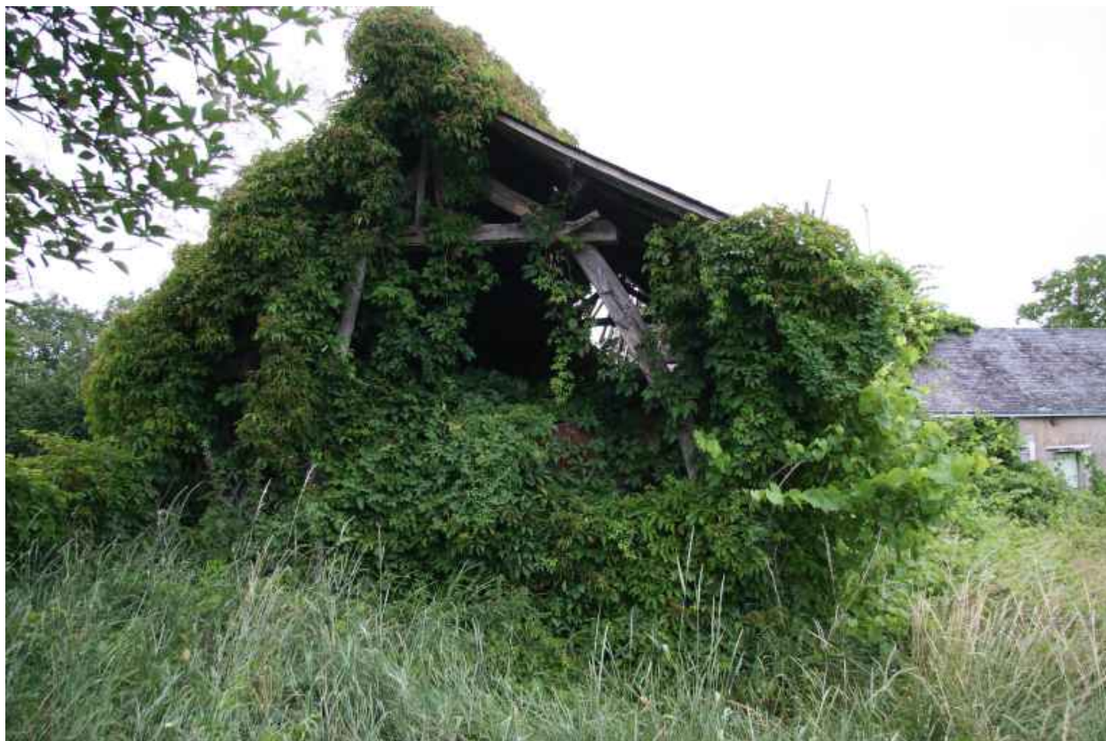
Maison 1 : pignon en charpente.
